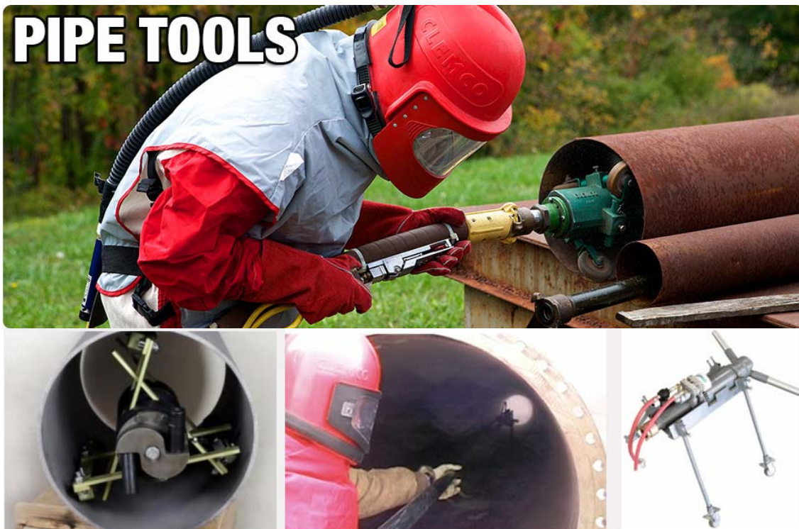
شکل-۴۶: تمیزکاری داخل لوله با استفاده از سندبلاست
