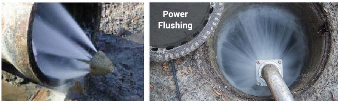
شکل-۳۷: نمونه ای از پاشش آب برای تمیز کاری سطح داخل پایپینگ از گرد و خاک
