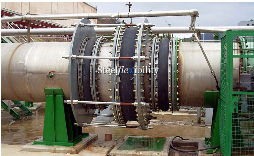
شکل-۸۸: نمونه ای از Expansion Joints از نوع Rubber-type
