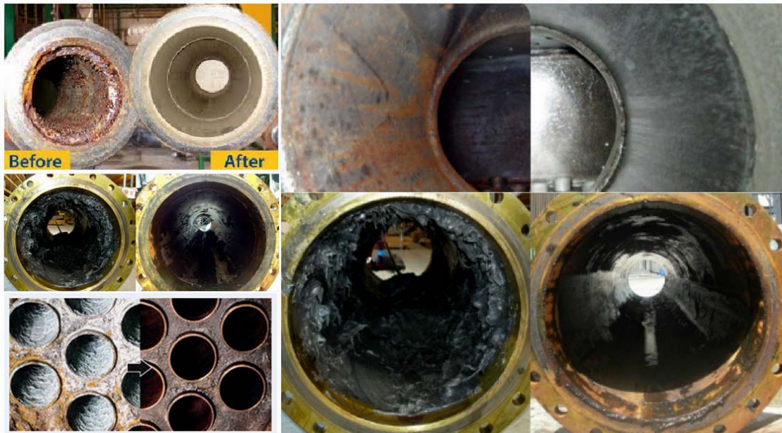
شکل-۴۹: تمیزکاری داخلی لوله با استفاده از مواد شیمیایی تحت عنوان Pickling
