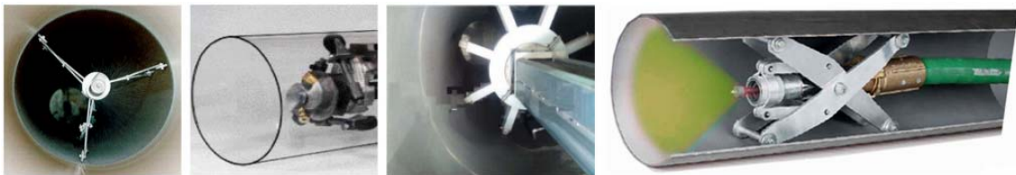
شکل-۴۵: تمیزکاری داخل لوله با استفاده از سندبلاست
