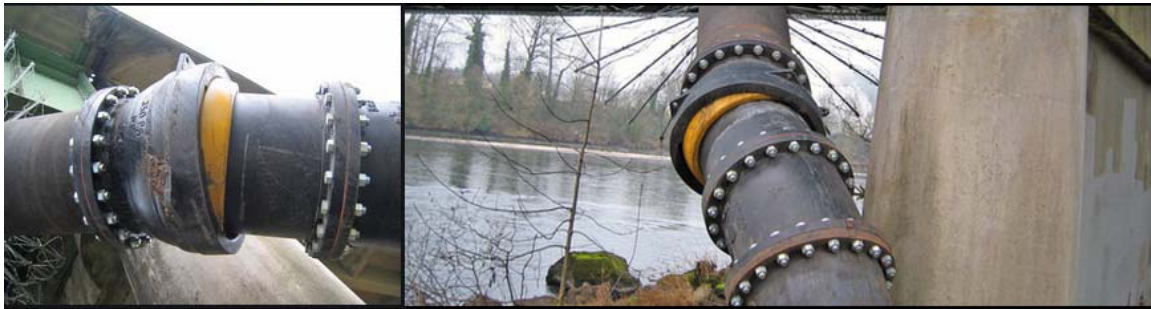
شکل-۸۳: نمونه ای از Expansion Joints از نوع Ball-types
