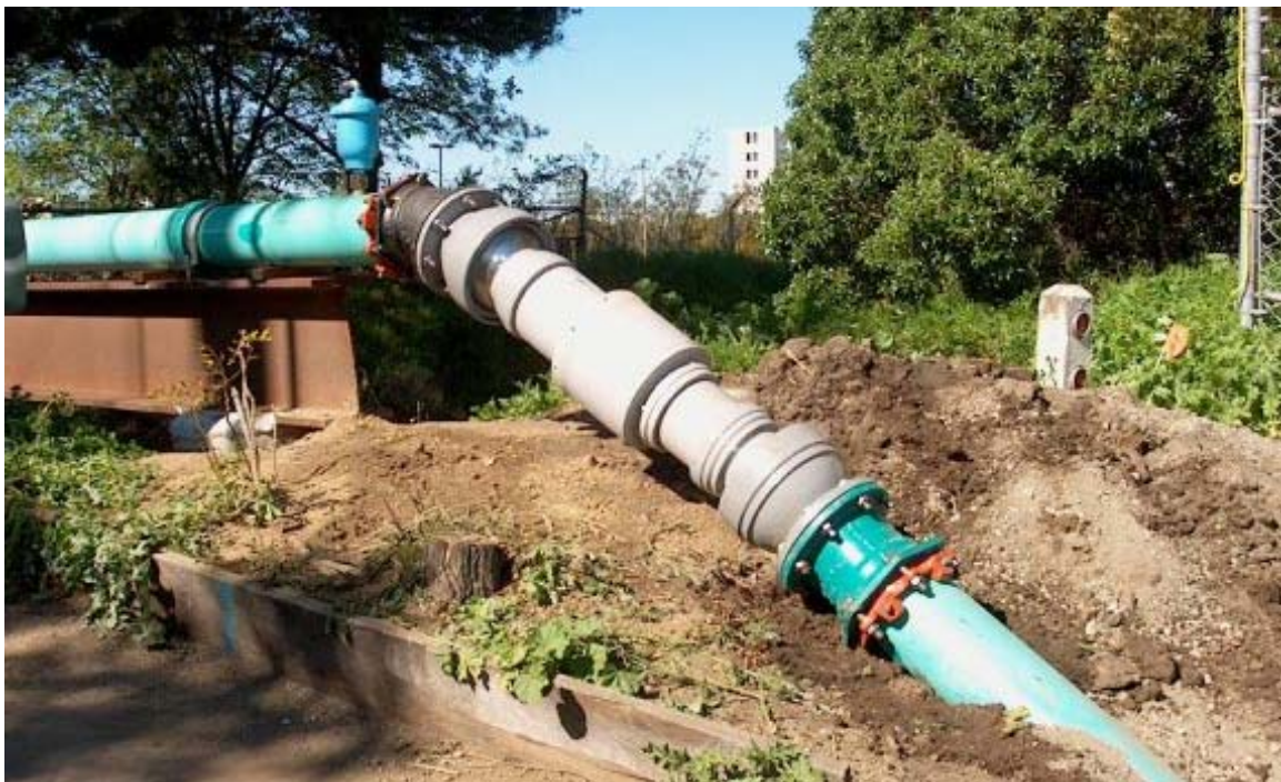
شکل-۸۴: نمونه ای دیگر از Expansion Joints از نوع Ball-types
