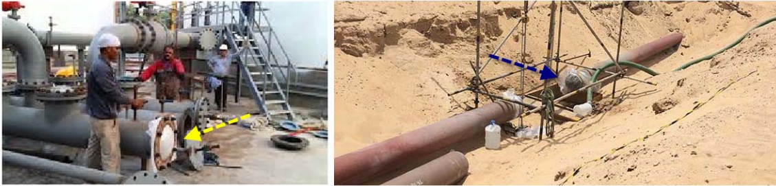
شکل-۶۳: نمونه ای از اجرای Flushing با هوا و استفاده از پلاستیک
