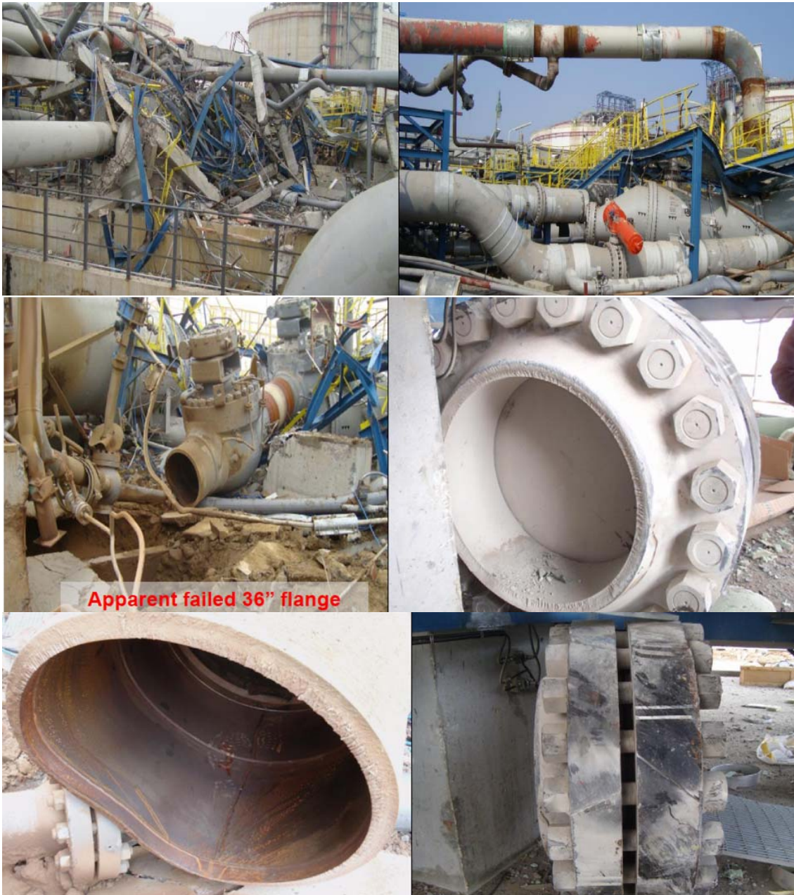
شکل-۹۳: خرابی های ناشی از انفجار تست هوا در لوله 36" روزمینی
