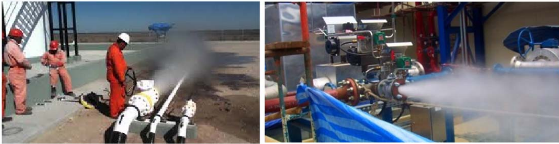
شکل-۳۸: نمونه ای از (Cleaning with water (water flushing)
